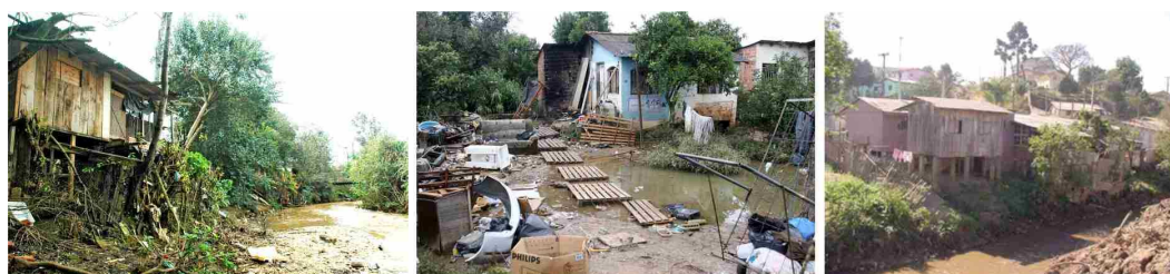
Figura 4 – Habitações na beira do RioAtuba no Jardim Marambaia antes da intervenção - Colombo
