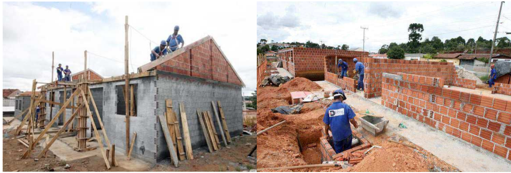
Figura 9 – Unidade em fase de construção - 2012
