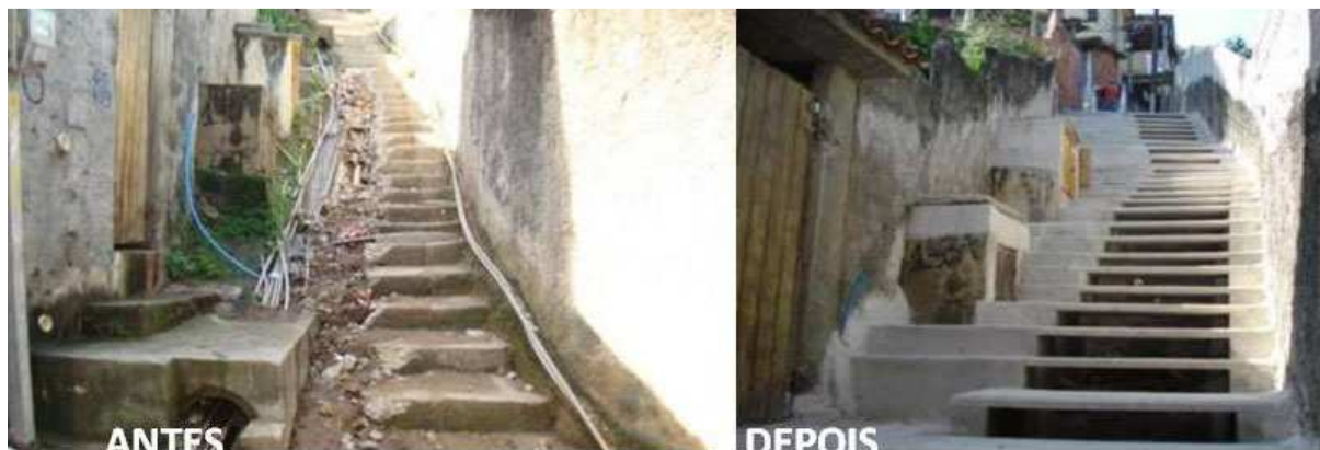
Fig. 6 Tratamento de escadaria com a solução de escadas drenantes
