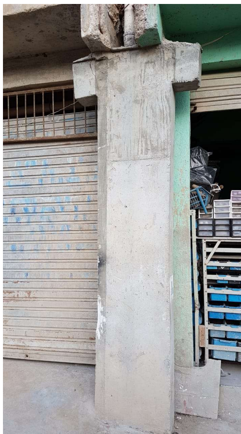
Figura 8: Reforço estrutural com radier estaqueado
