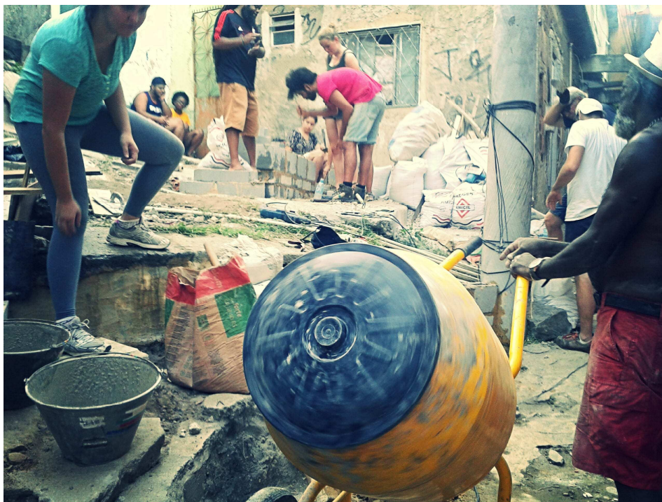
FIGURA 01: Mutirão de construção no beco Leste.
