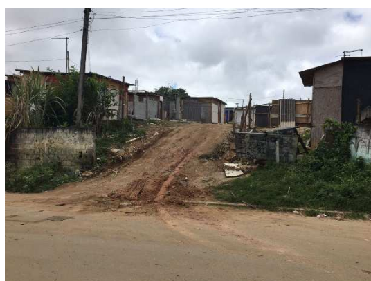
Figuras 6: Fotos do processo de consolidação
