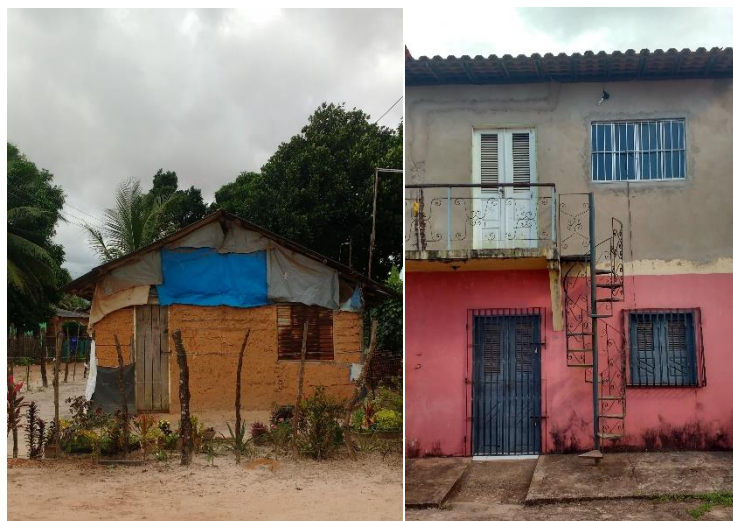
Figura 05: Dois exemplares de casas encontradas no bairro - a esquerda temos uma construída em taipa de mão e a direita uma casa de dois pavimentos que ocupa todo o lote.
