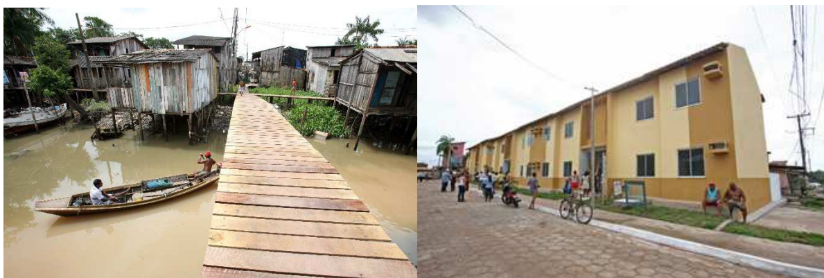
Figura 3 – Comunidade palafíticas e Bloco habitacional finalizado na área do PAC Taboquinha.
