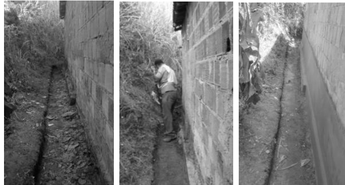
Fig. 4: Projeto Arquiteto da Família. Trabalho de impermeabilização e drenagem.
