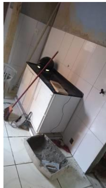
Figura 15: durante a reforma
