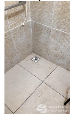
Figura 13: depois da reforma
