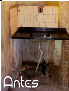
Figura 14: antes da reforma
