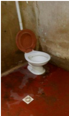
Figura 11: antes da reforma
