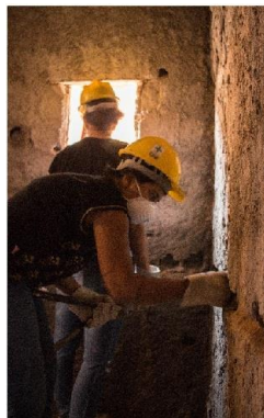
Figura 12: durante a reforma
