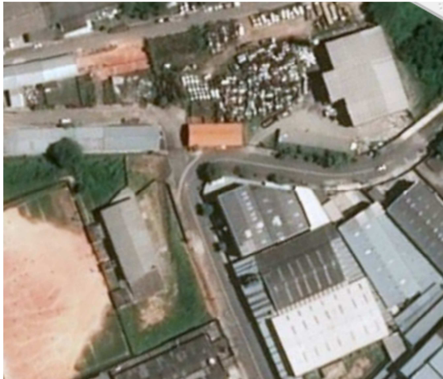
Imagem 2- Canto inferior esquerdo galpão de práticas de canteiro e canto superior direito edifício administrativo e de salas, localizados na Rua Porfírio Herdeiro 414 - Parque Industrial das Oliveiras, Taboão da Serra. Escala 1:2000
