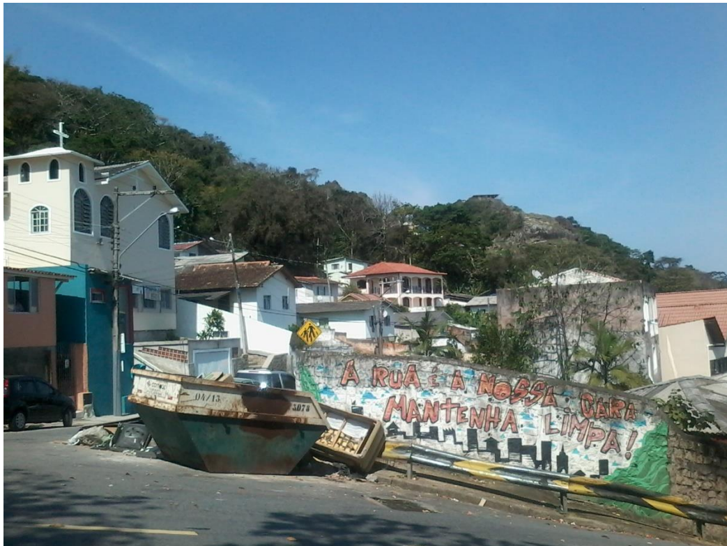
Figura 1 – Esquina das ruas General Vieira da Rosa e Nestor Passos, área central da comunidade do Monte Serrat
