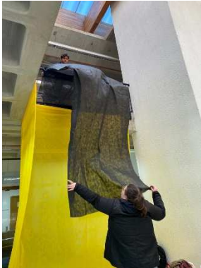
Figura 2: Execução de estrutura com tecido tensionado.
