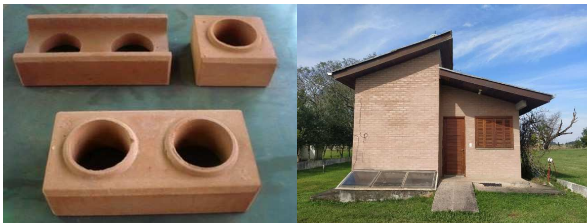
Figura 1. Exemplo do tijolo de solo-cimento utilizado no protótipo da UFSM.
