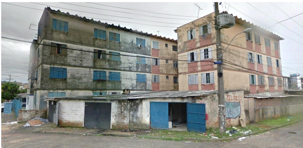
Figura 1: Ocupação dos espaços abertos no Conjunto Habitacional Rubem Berta
