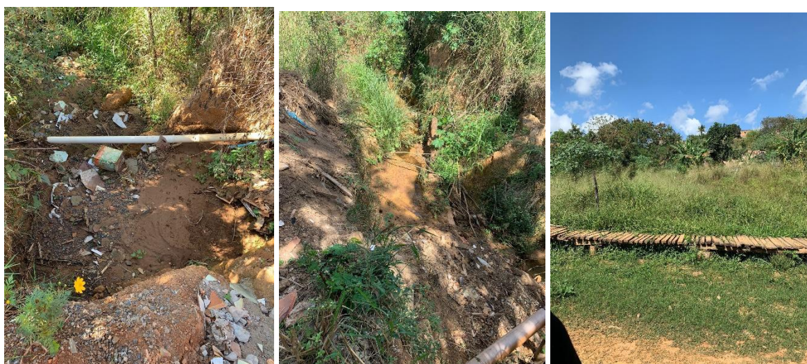
Figura 06: situação da nascente São José e seu caminhamento
