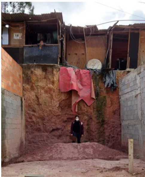
Figura 12: Corte a 90° de talude em um lote na Est. Portugal
