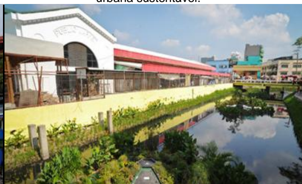
Figura 10: Estero de Paco com a nova infraestrutura urbana sustentável.
