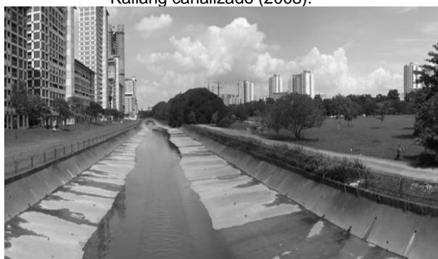
Figura 5: Parque Bishan-Ang Mo Kio com o Rio Kallang canalizado (2008).
