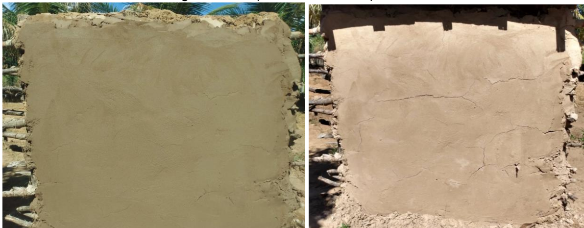
Figura 5: Protótipo rebocado e seco após 7 dias.
