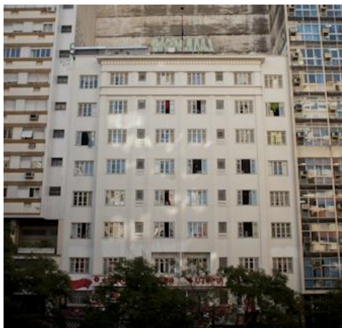
Figura 5: Edifício reabilitado para HIS (2011)
