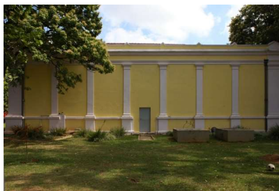
Figura 7: Reservatório de água
