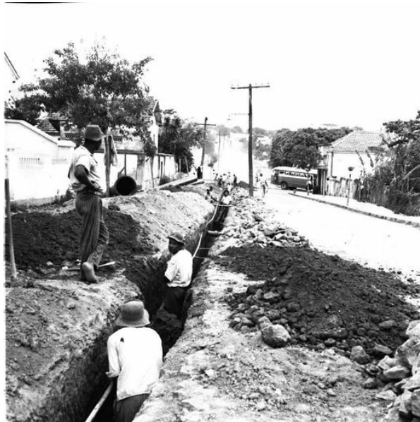
Figura 12: Obras de sub-adutora no bairro Cruzeiro, 1954
