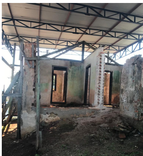
Figura 7: Escoras de Madeira
