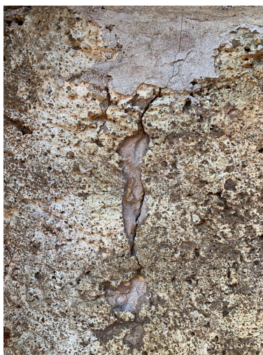
Figura 6: Situação das paredes e acabamentos
