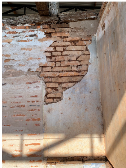
Figura 5: Situação das paredes e acabamentos
