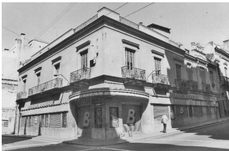
Figura 5: O Edifício Barreiro y Ramos antes da intervenção.
