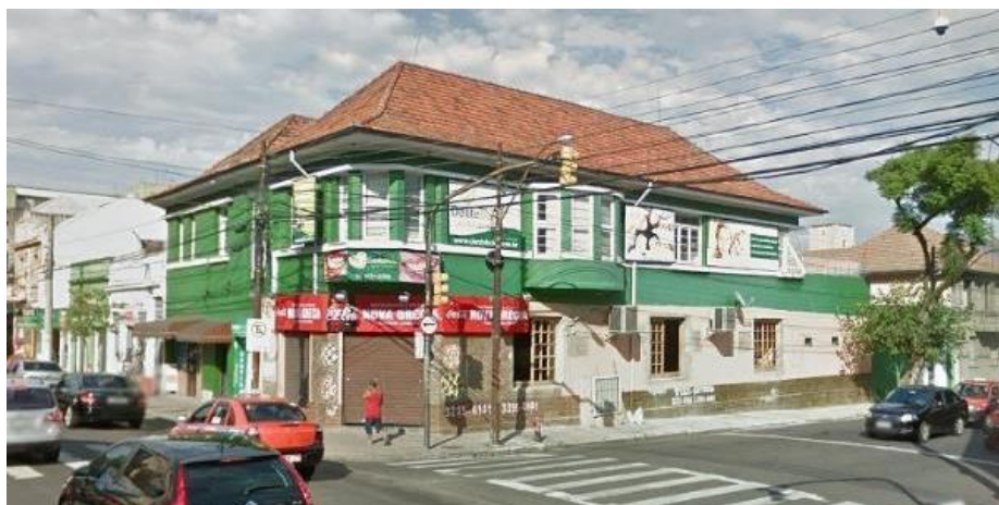
Figura 2: Edificação pré-moderna de linhas alemãs recentemente demolida no Bairro Floresta.
