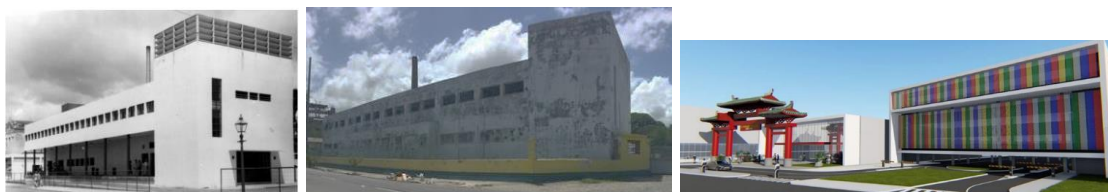
Figuras 23, 24, 25 – Da esquerda para a direita: Fachada original da CILPE no Cais José Mariano em 1935, seu estado atual, 2021 e Simulação volumétrica de divulgação do projeto, ângulo desconhecido. Fontes: Respectivamente, Memorial do Projeto de conservação e restauro ( https://bpm.recife.pe.gov.br/agiles/file/temporary?pk=9-x3zp5nkf5kqth0itl ); Acervo próprio; Apresentação do Empreendimento no CDU.
