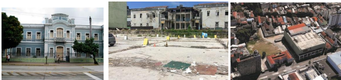
Figuras 26, 27, 28 - Edificação do Colégio Marista em avançado processo de degradação. Fontes: Instituto Boa Vista, Blog do Jamildo.
