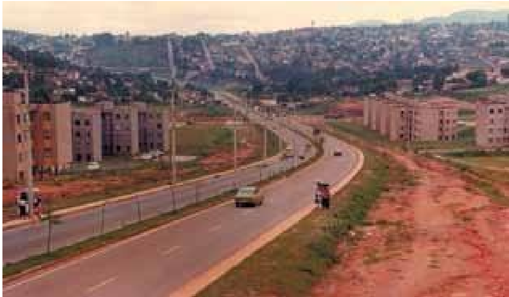
Figura 13 - Conjunto Habitacional Teixeira Dias na Via do Minério. Fonte: APCBH.
