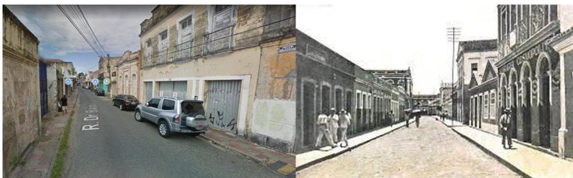
Figura 2: Rua Doutor Barata no passado e no presente
