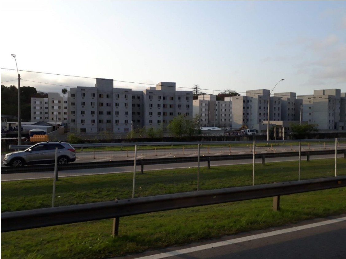
Figura 12. Empreendimentos imobiliários na gleba do antigo pátio industrial do Grupo Hime no bairro Neves em São Gonçalo. Fonte: Acervo do autor, setembro de 2021.
