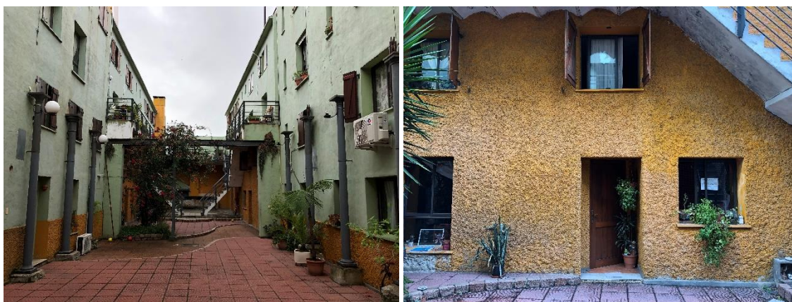
Figura 11 – Áreas comuns e unidade habitacional no conjunto COVIRAM.
