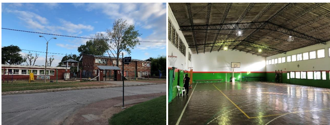
Figura 7 – Escola municipal e ginásio poliesportivo no conjunto habitacional Mesa 5.
