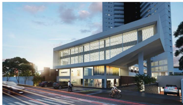
ROCA HOME & BUSINESS HABITACIONAL| EMPRESARIAL| SHOPPING -TORRE FORTE CONSTRUÇÕES
