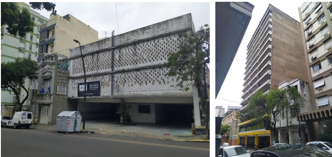
Figura 5: Estacionamentos tipo edificação
