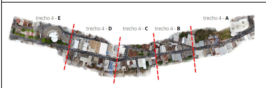
Figuras 14 a 19 - trecho 4: Avenida Salime Nacif
