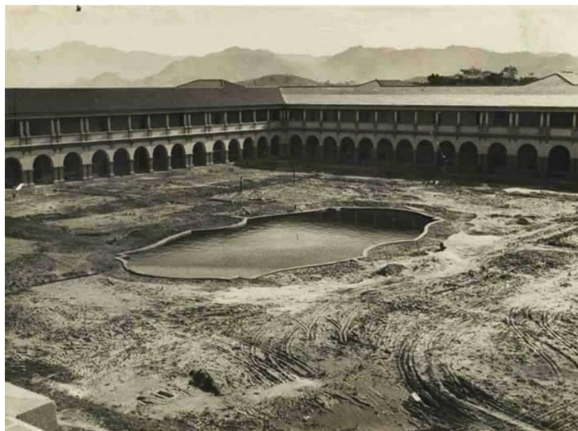
Figura 5: Pavilhão Central em construção na década de 1940.
