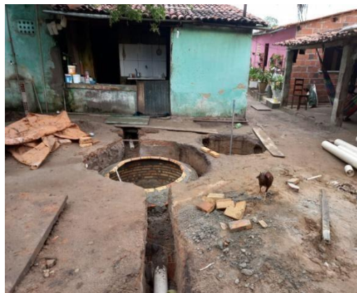
Figura 1 – Construção do Biodigestor no modelo chinês.
