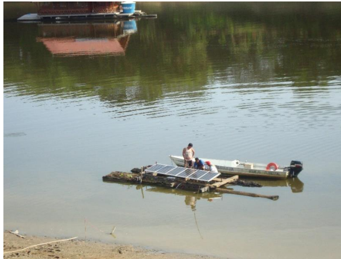
Figura 1: Instalação das placas solares em estrutura flutuante
