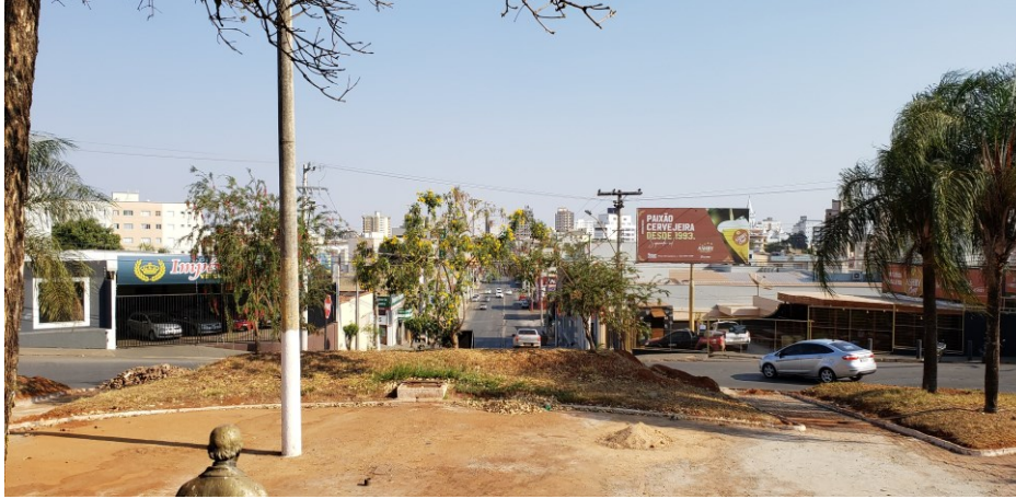
Figura 20 – Vista da Praça Champagnat (em obras)
