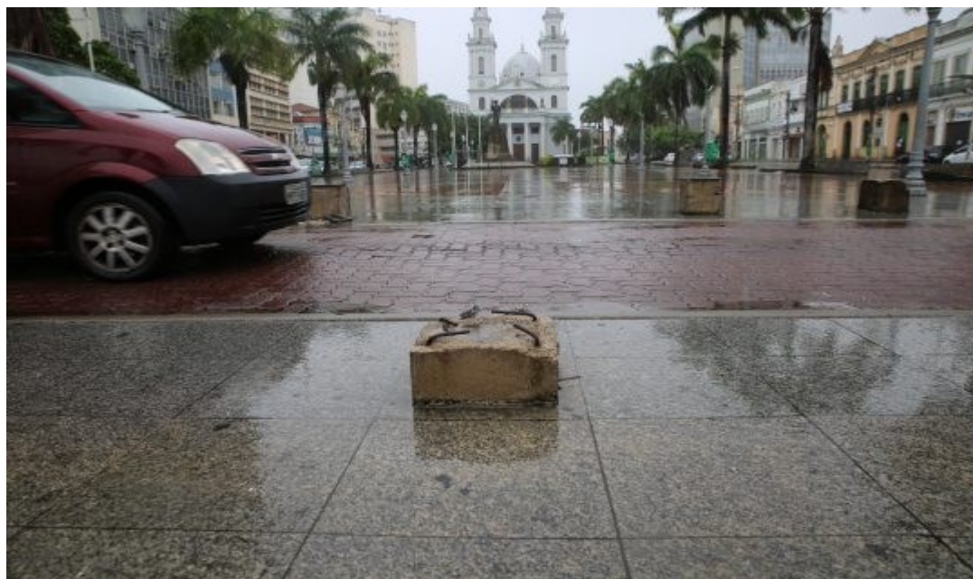
Figura 9: Estado de degradação da Praça São Salvador
