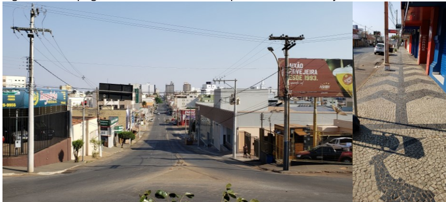
Figura 17 – Topografia e revestimento nos passeios da rua Major Gote
