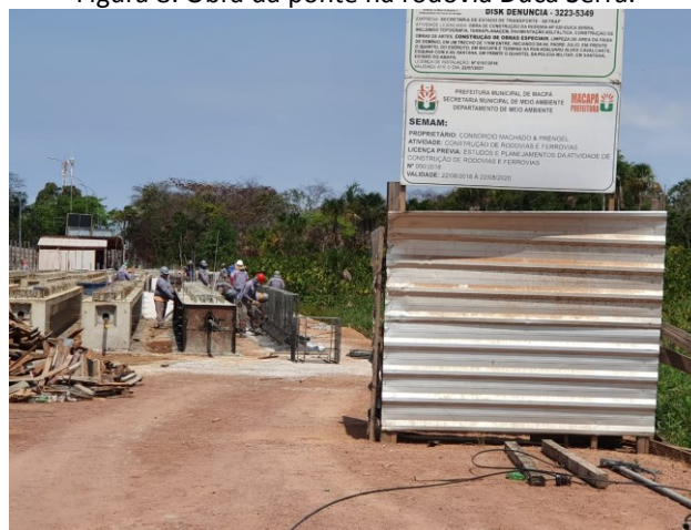
Figura 8: Obra da ponte na rodovia Duca Serra.
