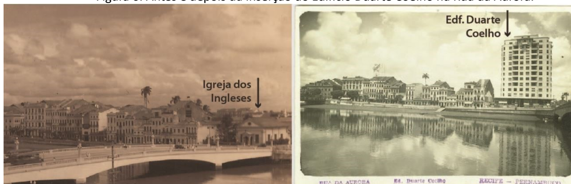
Figura 6: Antes e depois da inserção do Edifício Duarte Coelho na Rua da Aurora.
