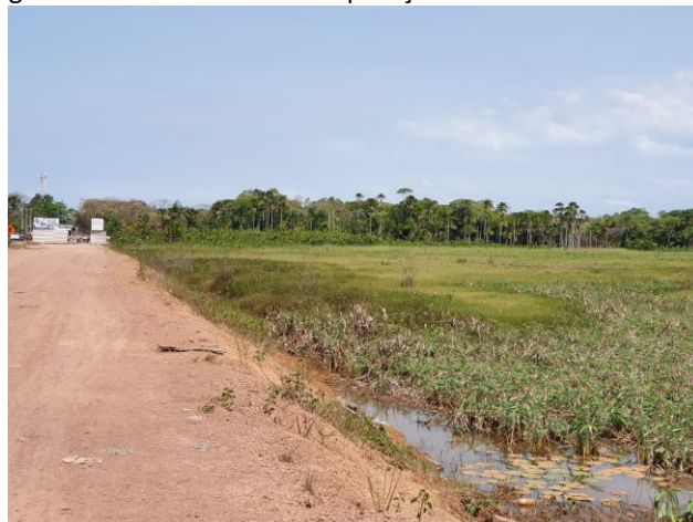
Figura 7: Aterro da obra de duplicação da rodovia Duca Serra.
