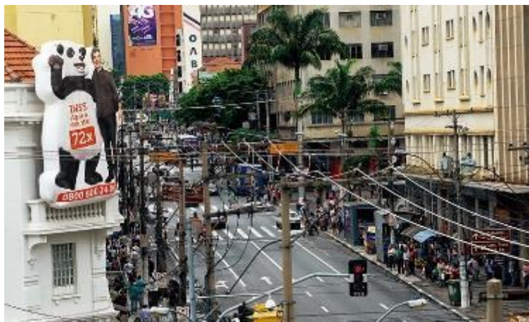
Figura 1: trecho da Avenida Francisco Glicério antes da revitalização.
