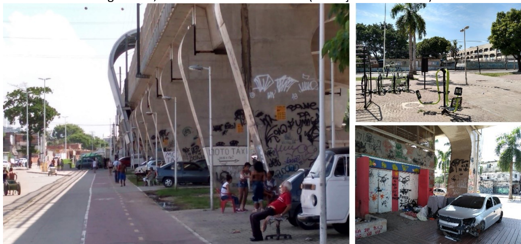
Figuras 15, 16 e 17: Fotos do trecho 5. (Transição entre 5 e 6.)
