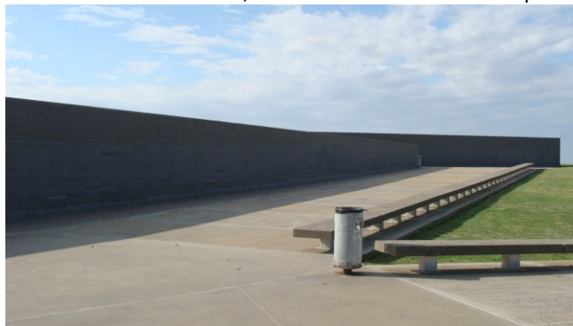
Figura 3: Passeio da muralha, muros com nomes dos desaparecidos
