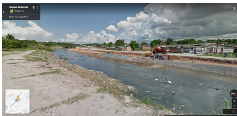
Figura 17. Obra de restrição do leito em junho de 2012.
