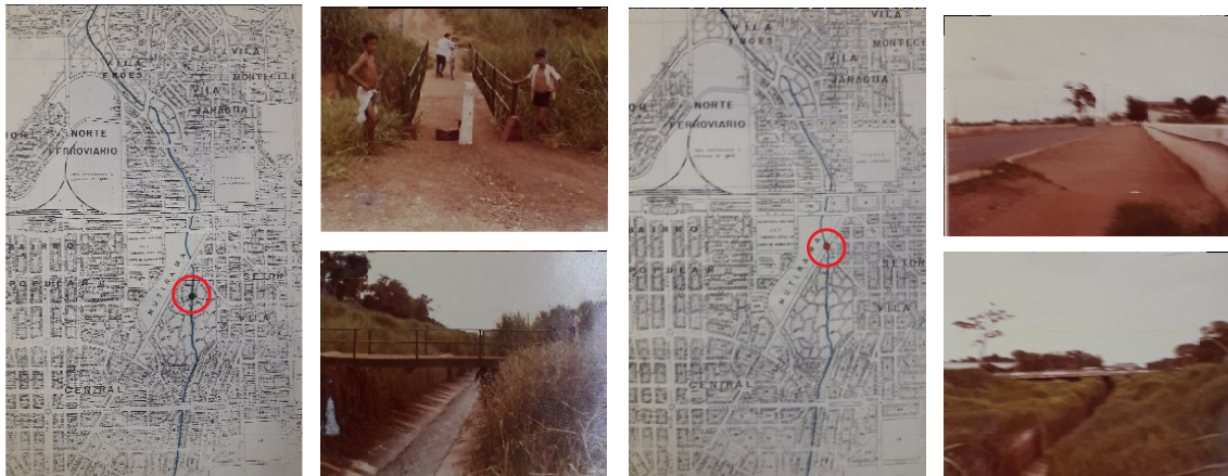
Figura 15: Canalização do Córrego e ocupações irregulares em 1976.
