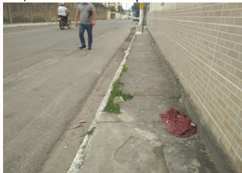
Figura 5 - Calçadas estreitas, com materialidade precária na faixa livre e sem sinalização tátil.
