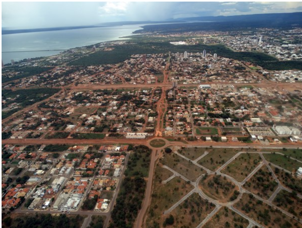
Figura 3: Vista panorâmica da cidade de Palmas-TO.
