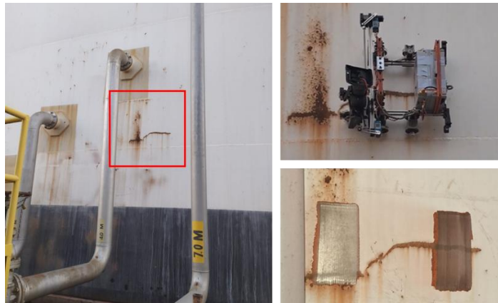
Figura 10 – Teste de preparação com o Crawler no tanque esférico desativado da REGAP.
