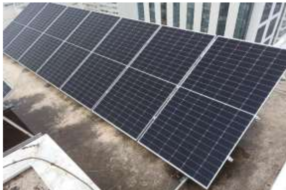
Figura 2 – Painéis Solares EMSH550HC (Intelbras)
