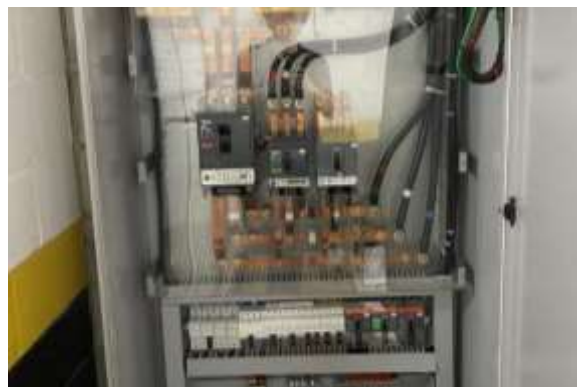
Figura 4 – Painel de paralelismo modificado para usina híbrida
