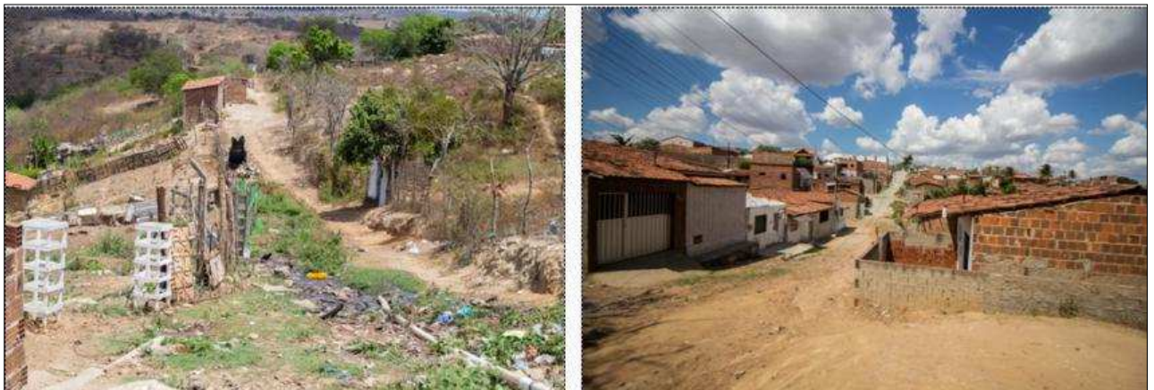
Figura 7 e 8 – Falta de saneamento básico e mobilidade urbana no Jardim Europa
