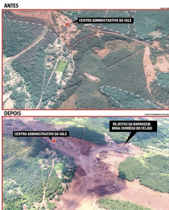
Figura 2: Área atingida pelos rejeitos da Barragem Mina Córrego do Feijão
