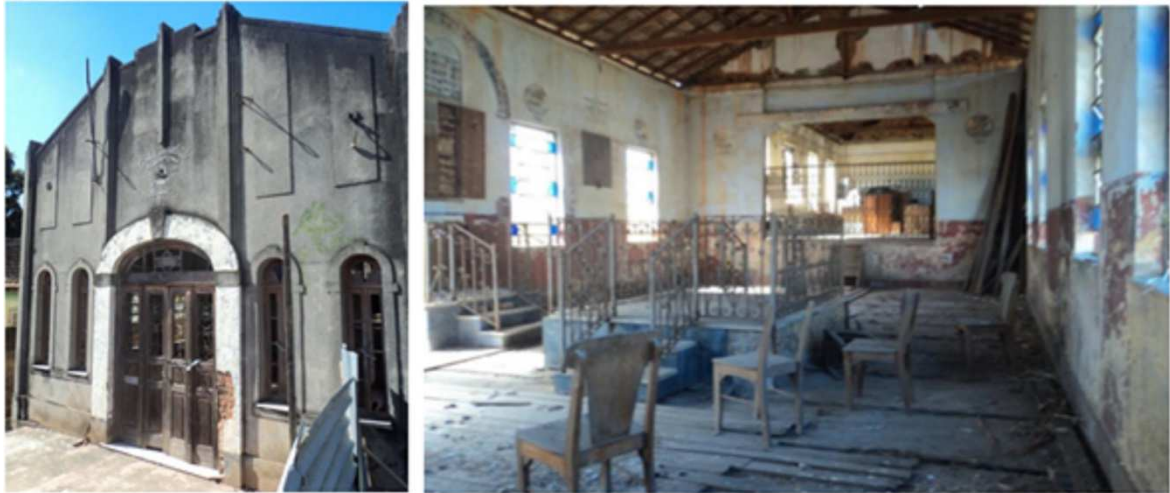
Figura 2: Fachada e interior da Sinagoga Tiferet Israel
