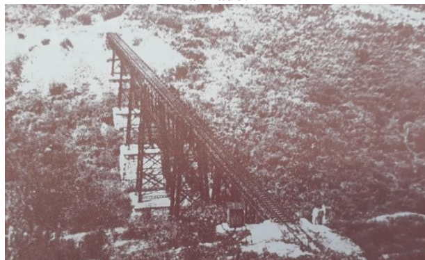
Figura 2: Viaduto da Grota Funda, antiga Estrada de Ferro de Pernambuco, que foi reconstruída em concreto armado.
