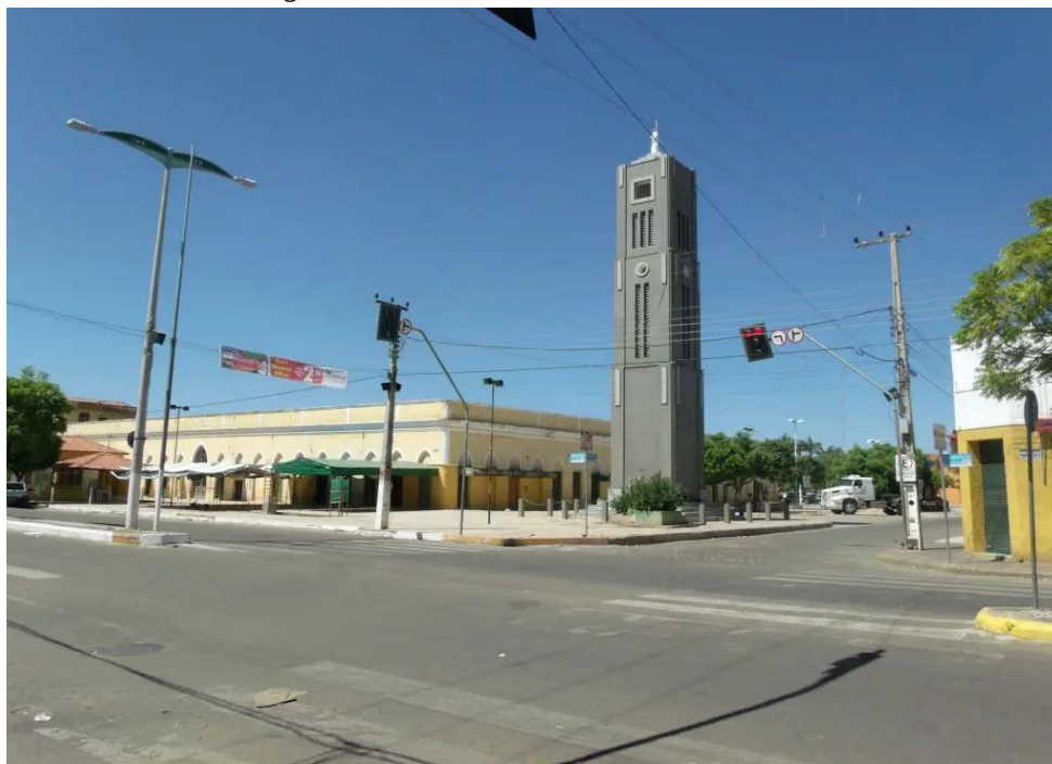
Figura 1 – Fachada do Mercado Público de Icó
