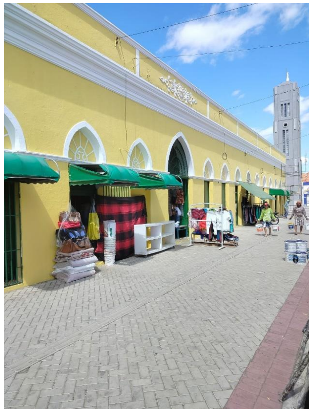
Figura 4 – Estilo arquitetônico do mercado público de Icó
