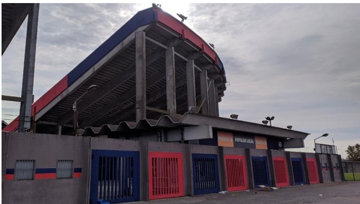
Figura 8 – Instalações do Estádio Pedro Bidegain, no bairro de Bajo Flores
