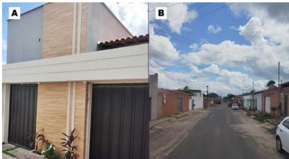
A: Residência com estrutura alterada; B: Rua principal do conjunto.
