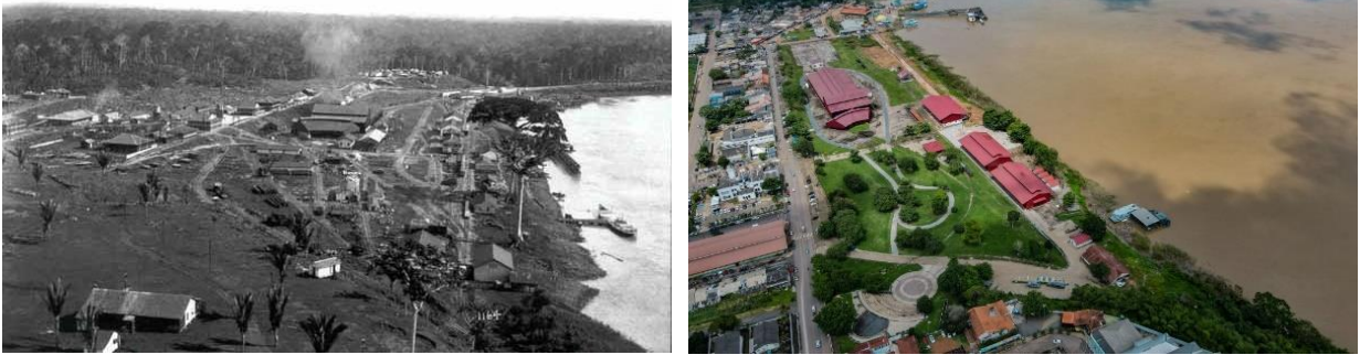
Figuras 04 e 05: Fotografia da construção da EFMM; EFMM (2022).
