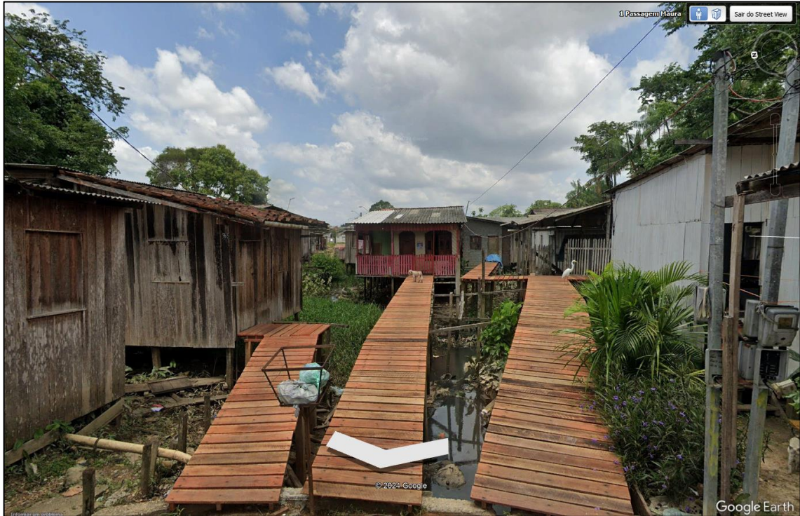
Figura 2: imagem de logradouro em pontes e residências em palafitas – Belém.
