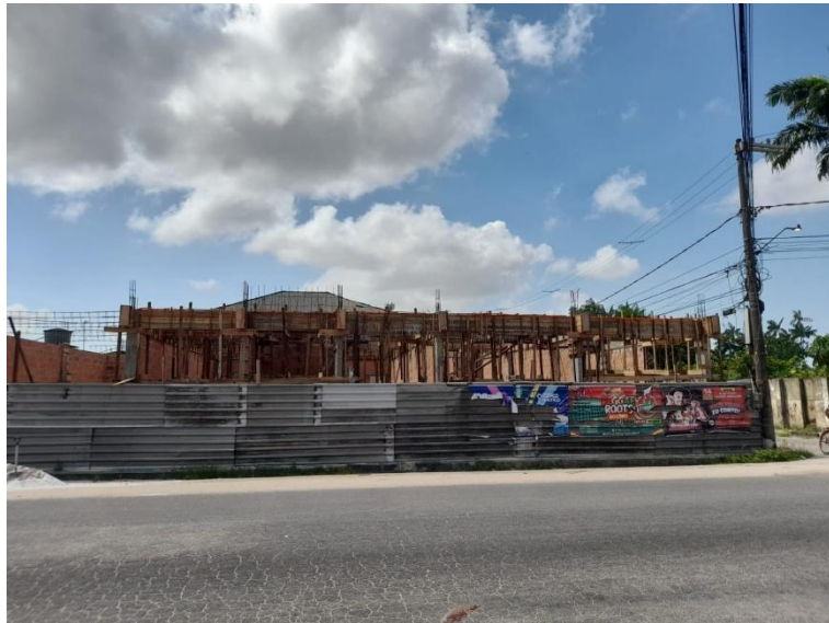
Figura 4: Construção de futuros lotes comerciais na Avenida Principal, Alameda 2.
