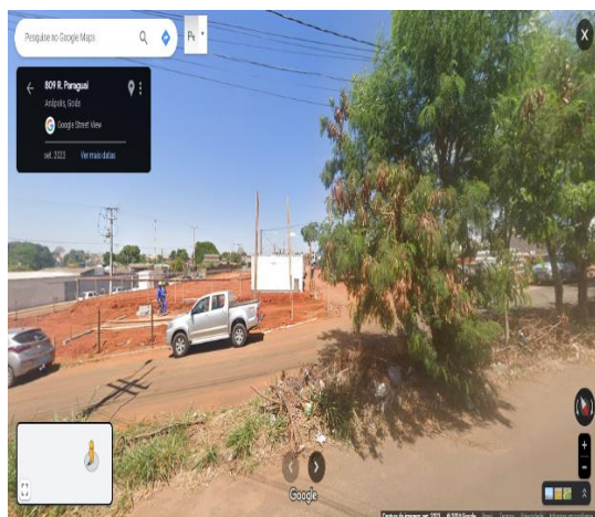
Figura 1- Canteiro de Obras.
