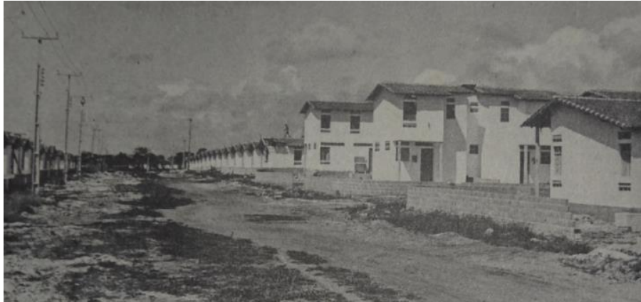
Figura 4 – Construção da etapa Mangabeira I
