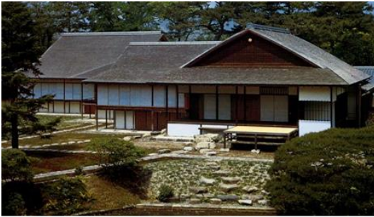
Figuras 07: Deck na fachada
